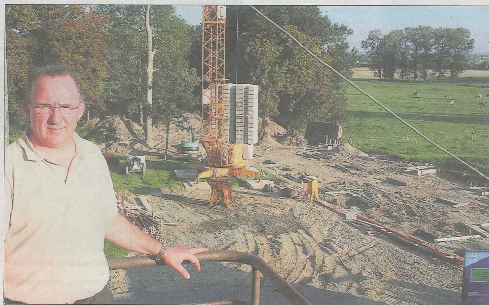
■ Olivier Deville, directeur de la maison familiale de Vains, devant le chantier du futur pôle pédagogique dont les travaux ont commencé le lundi 5 septembre et qui sera achevé au 30 juin 2012.
